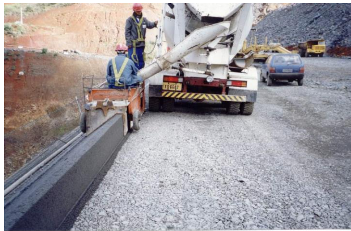
Figura 9.- Construcción de bordillo en El Cajón, Nay.
