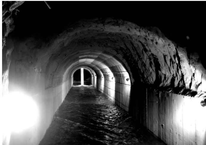
Figura 1. Túnel de rugosidad compuesta del P.H El Cajón, vista hacia aguas arriba.
